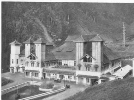
5. Gebouw van het station Malabar.
